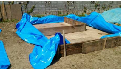
練混ぜの為の内枠を設置します
