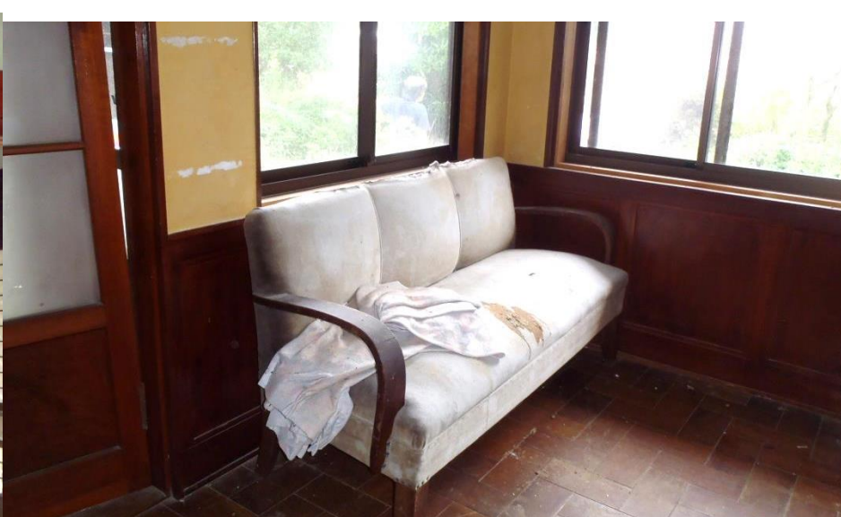
S25頃増築の応接間
