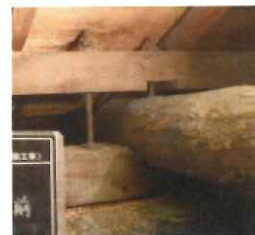
写真3. 改修前和小屋の様子
