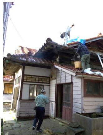
古瓦で土嚢を作りブルーシートを抑える作戦
