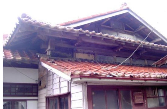
入母屋部分の瓦と外壁の納まり
