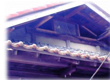
入母屋部分の瓦と外壁の納まり
