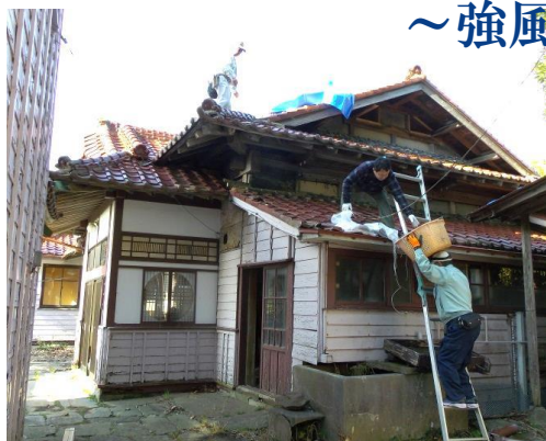
古瓦で土嚢を作りブルーシートを抑える作戦
