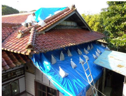
台所屋根を包み込み 完了
