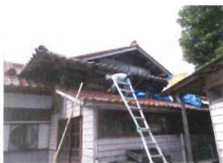
“そろ窓”をスッパリ覆う。 木枠組みが壊れて、ガラスに隙間が出来ている
