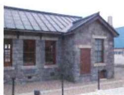
写真6. 改修後外部の様子
