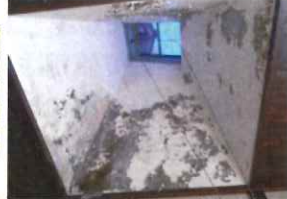
“そろ窓”をスッパリ覆う。 木枠組みが壊れて、ガラスに隙間が出来ている
