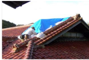
“そら密”をスッポリ覆う。 木枠組みが壊れて、ガラスに隙間が出来ている
