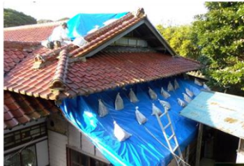
雨漏れ防止作業
