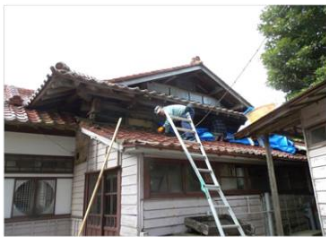
“そら密”をスッポリ覆う。 木枠組みが壊れて、ガラスに隙間が出来ている
