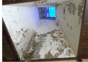
“そら密”をスッポリ覆う。 木枠組みが壊れて、ガラスに隙間が出来ている
