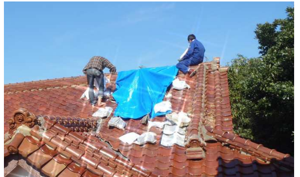
← 屋根の上では そら窓部分に 雨漏れ防止の ブルーシート 掛け替え。 4人で奮闘中
