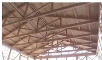
流通製材と住宅用プレカットによる 12m x 11m 山形トラス
