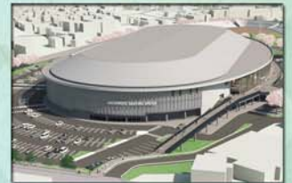
八戸市屋内スケート場
